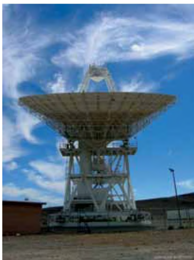
Рис. 1.12. Бистатистическая РЛС «Голдстоун», передающая и приемная антенны
